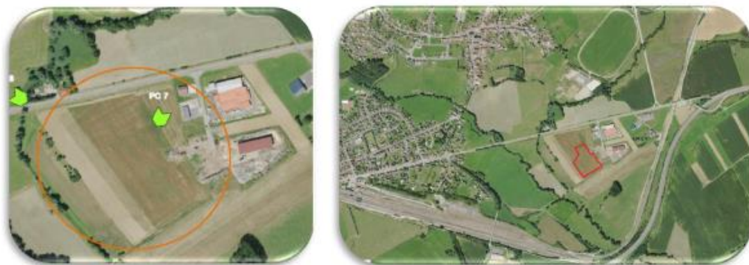
Figure 49 : Vue générale du site de méthanisation à Réding – Source : Projet initial de méthanisation territoriale de la Sarre porté par VOL-V Biomasse
